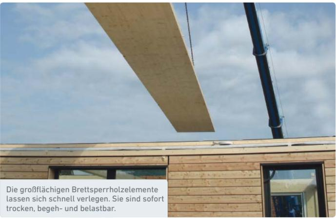
Die großflächigen Brettsperrholzelemente lassen sich schnell verlegen. Sie sind sofort trocken, begeh- und belastbar.
