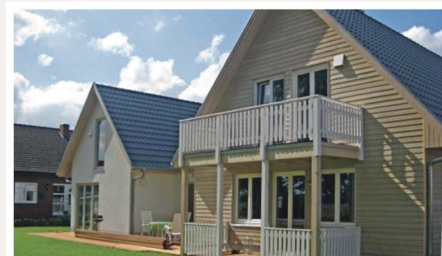
FASSADE Keilspundwände und Putzträgerplatte
