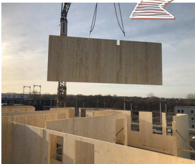
Aus einem Stapel Rundholz werden Bretter gesägt. Durch kreuzweise Verklebung einzelner Brettlagen entsteht aus den kleinformatischen Holzquerschnitten ein einfacher Werkstoff mit Platten- bzw. Scheibenwirkung. Brettsperrholz wird auch als KLH (Kreuzlagenholz)
