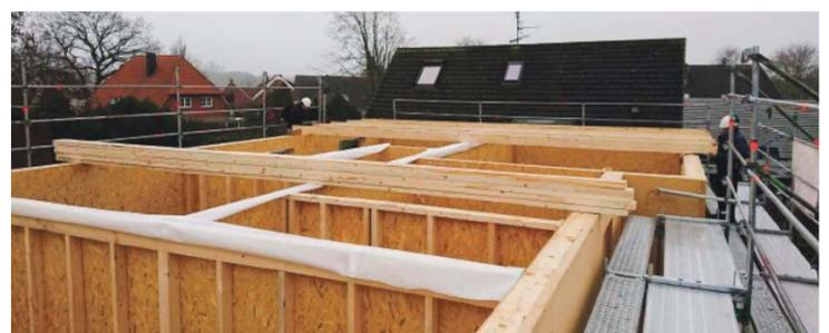
Nach dem ersten Tag stehen alle Außen- und Innenwände.
