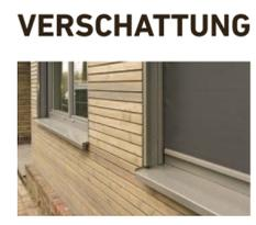
So sehr ausreichendes Tageslicht gewünscht wird, eine Blendung oder Reflexionen durch Sonneneinstrahlungen können sehr stören. Hinzu kommt die Überhitzung. Sonnenschutzvorrichtungen wie Raffstores sorgen für Abhilfe. Die Wirksamkeit dieser Einbauten wird durch den Abminderungsfaktor F<sub>v</sub> beschrieben. Nur mit einem außen liegenden Sonnenschutz lässt sich eine Überhitzung von Räumen im Sommer effektiv verhindern (siehe unten).
