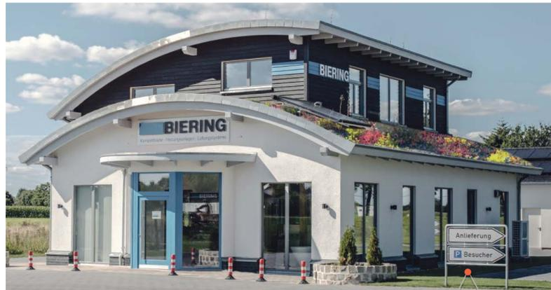
Wie sich eine ökologische Bauweise und moderne Gebäudetechnik ideal ergänzen, zeigt dieses Büro- und Ausstellungsgebäude. Es wurde für einen Sanitär- & Heizungsinstallationsbetrieb in Holzrahmenbauweise errichtet. 70 % der hier verwendeten Baustoffe bestehen aus nachwachsenden Rohstoffen: die Dämmung aus Zellulose, die Fenster aus Lärchenholz und die Fassade des Staffelgeschosses (Büro Räume) aus einer Bekleidung mit Douglasienholz. Die Bogen-
