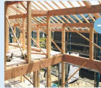
Foto: Pin-connected post and beam house framing, lizenziert unter CC BY 3.0
