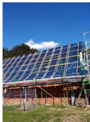
Auf der Dämmebene wurde eine Unterspannbahn verlegt, die das mögliche Eindringen von Regen und Schnee verhindert.
