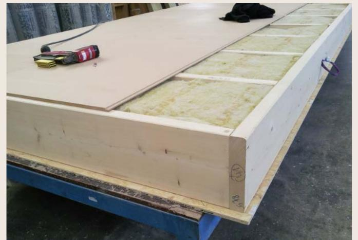
Die Holzrahmenbauweise ist für Wohnkuben bestens geeignet. Das Rahmenwerk wird voll ausgedämmt, der schlanke Wandquerschnitt ermöglicht mehr Wohn- und Nutzfläche und ein geringeres Gewicht. Im Gegensatz zu mobilen Tiny Houses, bei denen eine sehr geringe Wandstärke (Platzbedarf, Gewichtsreduzierung) wichtig ist, können Wohnkuben, die über ei-
