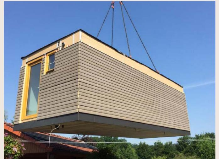
Neben den Vorteilen für das Wohnungs- bzw. Raumangebot punktet der Wohnkubus in Hinblick auf Nachhaltigkeit: Er bietet viele Nutzungsoptionen an und ermöglicht sogar einen Standortwechsel. Das Mini-Wohnhaus ist mit einem Boden ausgestattet und wird auf Punkt- oder Streifenfundamente aufgesetzt. Auch einschraubbare Punktfundamente sind möglich. So ist es über viele Jahre als Behausung oder Arbeitszimmer nutzbar, egal an welchem Ort.
