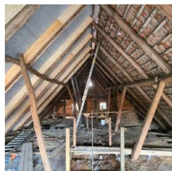
Die vorhandene Balkenlage wurde ausgeglichen, damit ein neuer stabiler Fußboden entstehen konnte.
