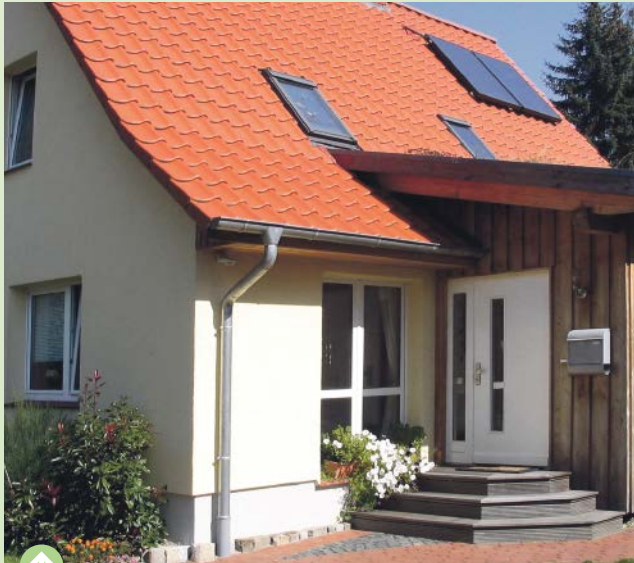
Bei diesem Anbau ist der Zugang seitlich angeordnet. Die Holzbekleidung des Anbaus ist als Boden-Deckel-Schalung aus Lärche ausgeführt, die mit dem zarten Gelbton der Putzfassade gut harmoniert.
