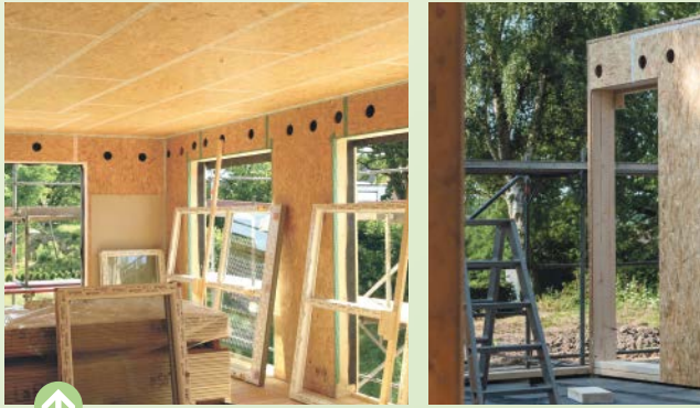
Die Holzrahmenbauweise eignet sich hervorragend für Anbauten. Die Wände werden vorgefertigt und können innerhalb kurzer Zeit am Gebäude montiert werden. Trocknungszeiten während der Bauphase entfallen völlig.
